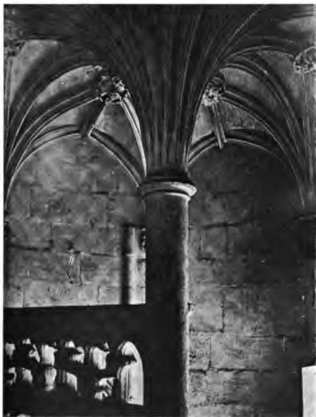
Fig. 103. — Couronnement de l'escalier du logis Barrault à Angers. xv e siècle. Prolongement du noyau de l'escalier circulaire, pour soutenir les nervures de la voûte annulaire.
